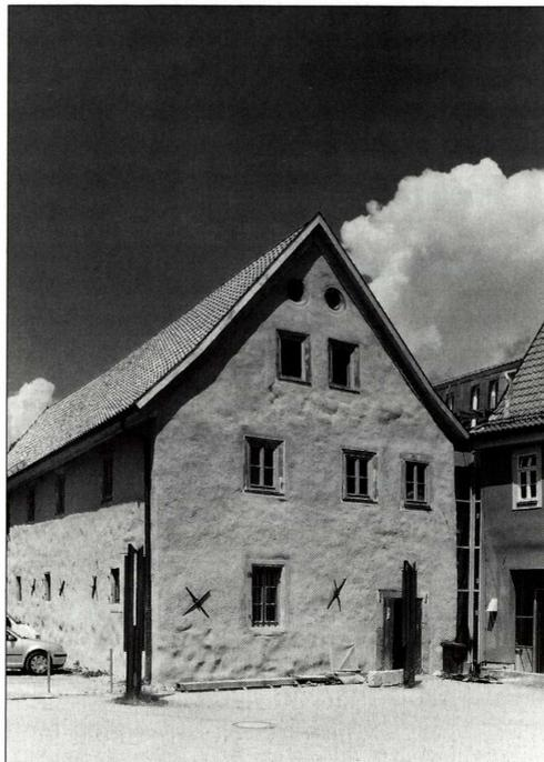
Die Kemenate wurde mit Saniermörtel überputzt.
