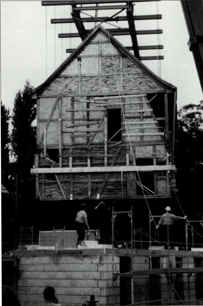
*Zur Sicherung der Altsubstanz wurde das Obergeschoss des Eckhauses bis zur Fertigstellung des neuen Kellergeschosses zur Seite gehoben und danach wieder aufgesetzt.*
