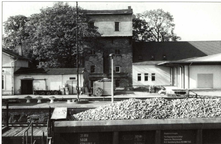
Vor der Sanierung war der Wasserturm ein unscheinbares Gebäude.
