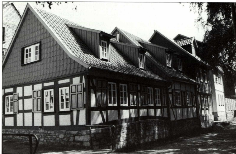
Sanierte Wohnhäuser „Am Mühlenwehr“
