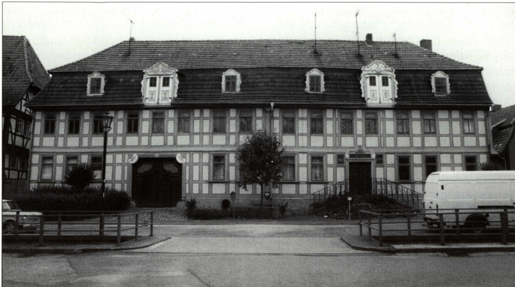
Der „Doppelhauscharakter“ des barocken Fachwerkbaus Haus „Schoetensack“ ist hier deutlich zu erkennen.
